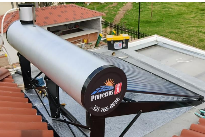
Calentador a gravedad 300 L con bomba presurizadora
