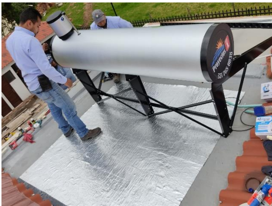
Instalación reflector de aluminio en el piso
